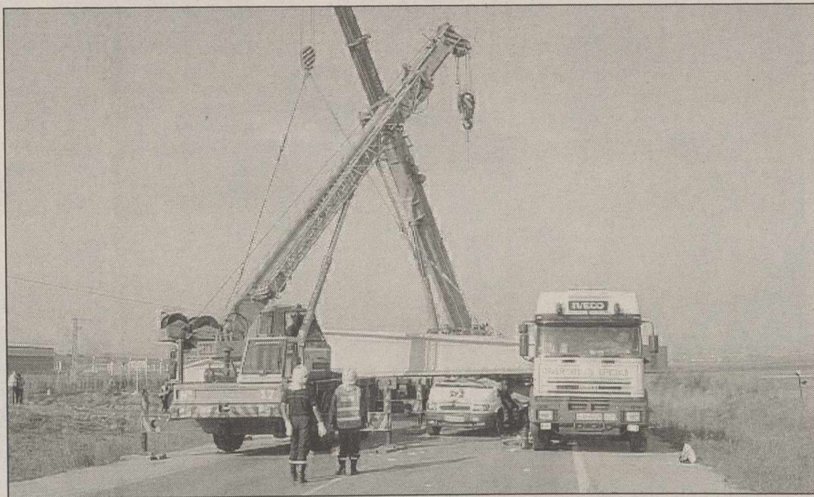
Fue necesario el empleo de grúas para sacar la ambulancia del amasijo de las vigas. BONETE
