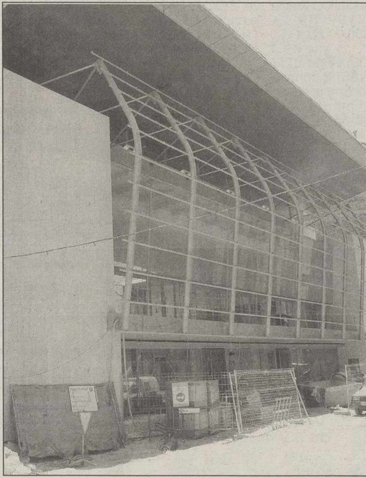
Obras de restauración del Teatro Circo.
