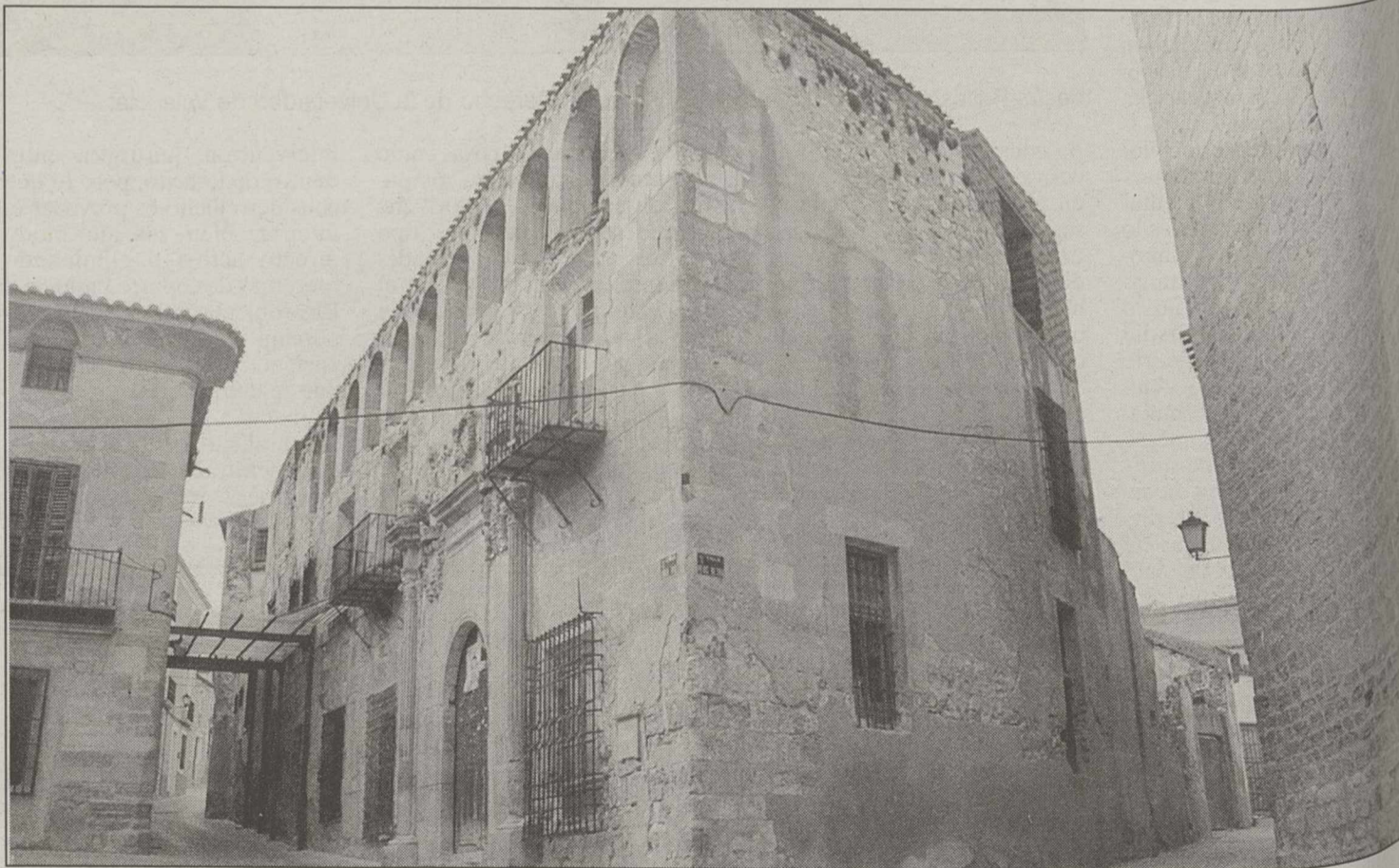
Chinchilla ha presentado 16 solicitudes de ayudas al programa de rehabilitación "A plena luz".
