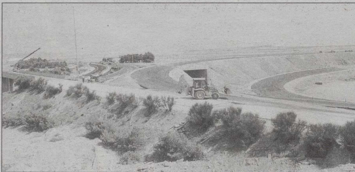
Las obras de la autovía de Murcia a su paso por Albacete, son un punto conflictivo.
