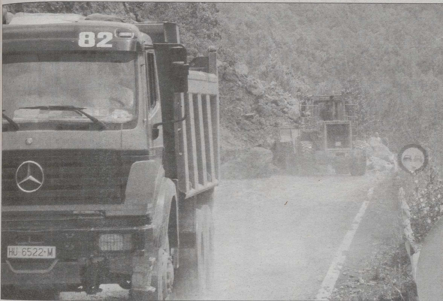
Obras de limpieza en una carretera cortada por desprendimientos en Huesca.
