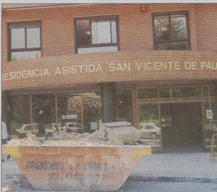
Se modifica la entrada de la residencia de mayores.
