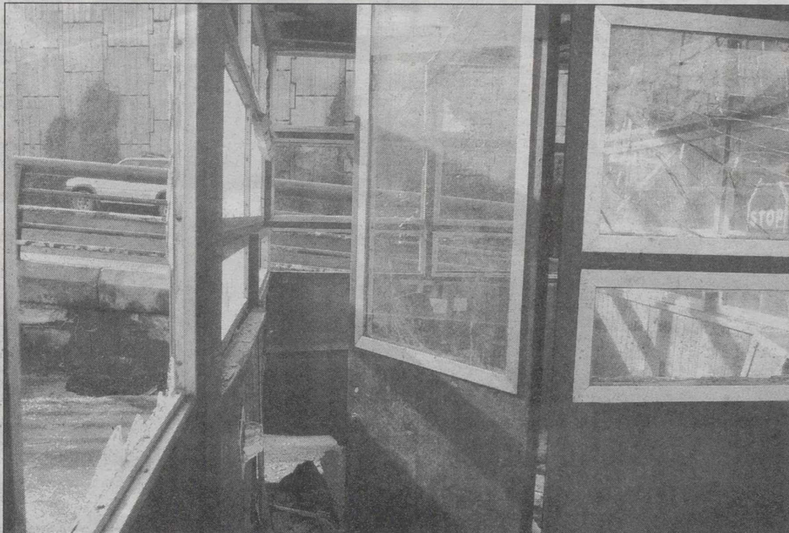
La explosión de un artefacto ha causado diversos daños en una garita de la Guardia Civil.
