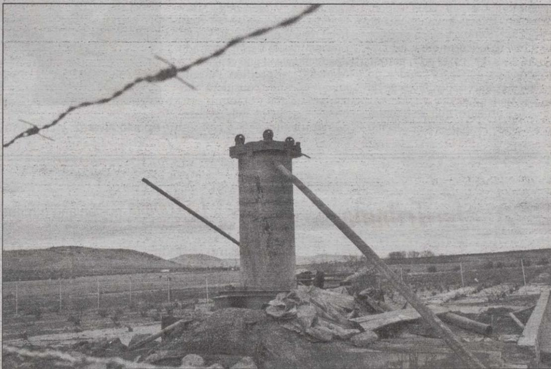
El tubo metálico por donde ascendía la columna de agua y arena.
