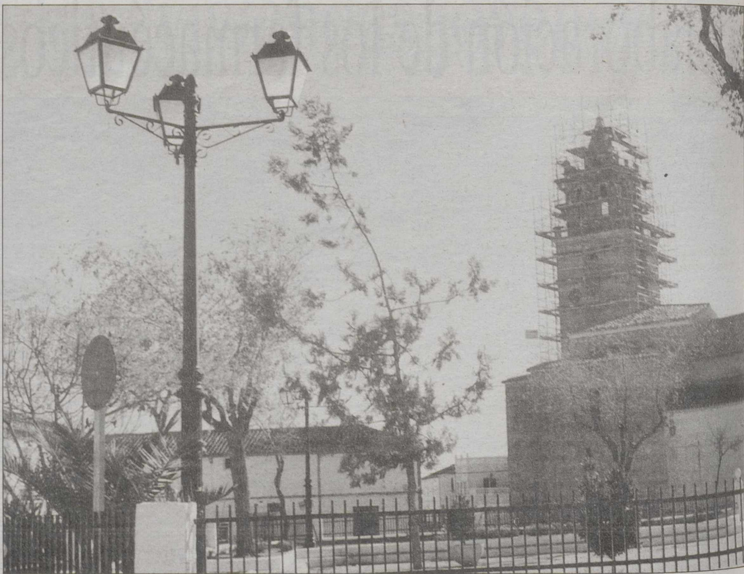
Obras de reparación de la torre de la iglesia parroquial de Barrax.
