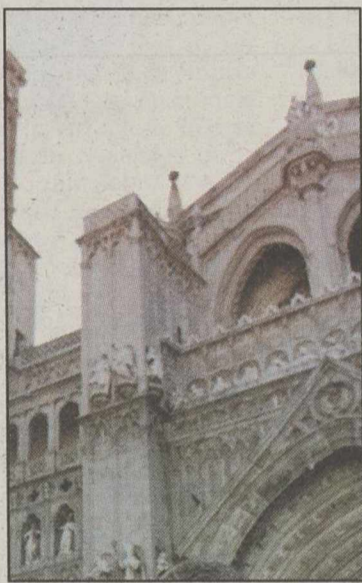
Obras en la catedral. ARCHIVO
