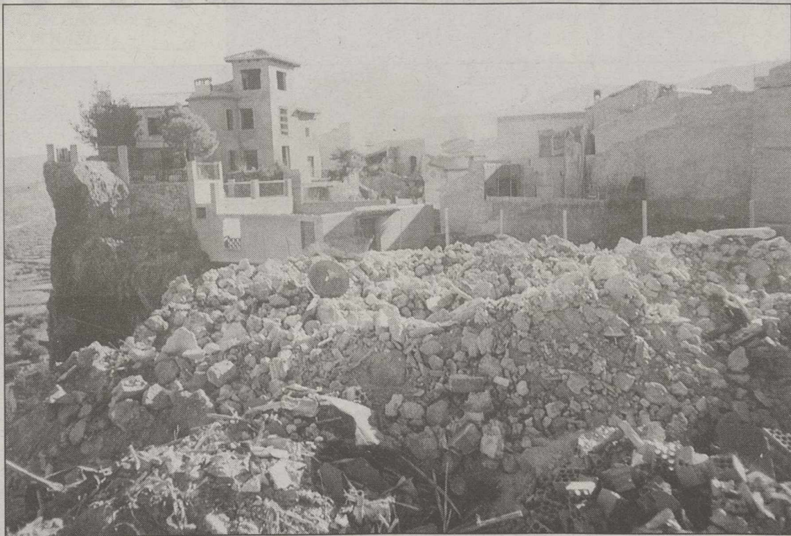
La Asociación Protectora denuncia los deterioros por las distintas obras.
