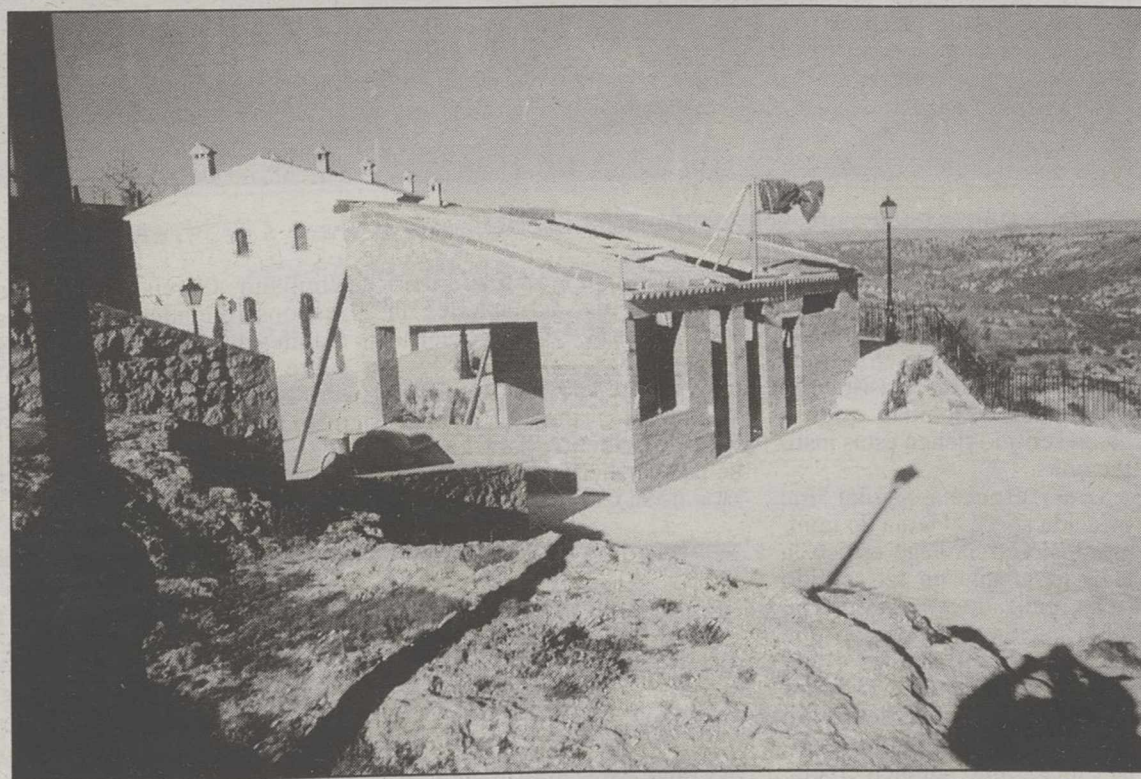
Piden estudios racionales antes de comenzar los trabajos.
