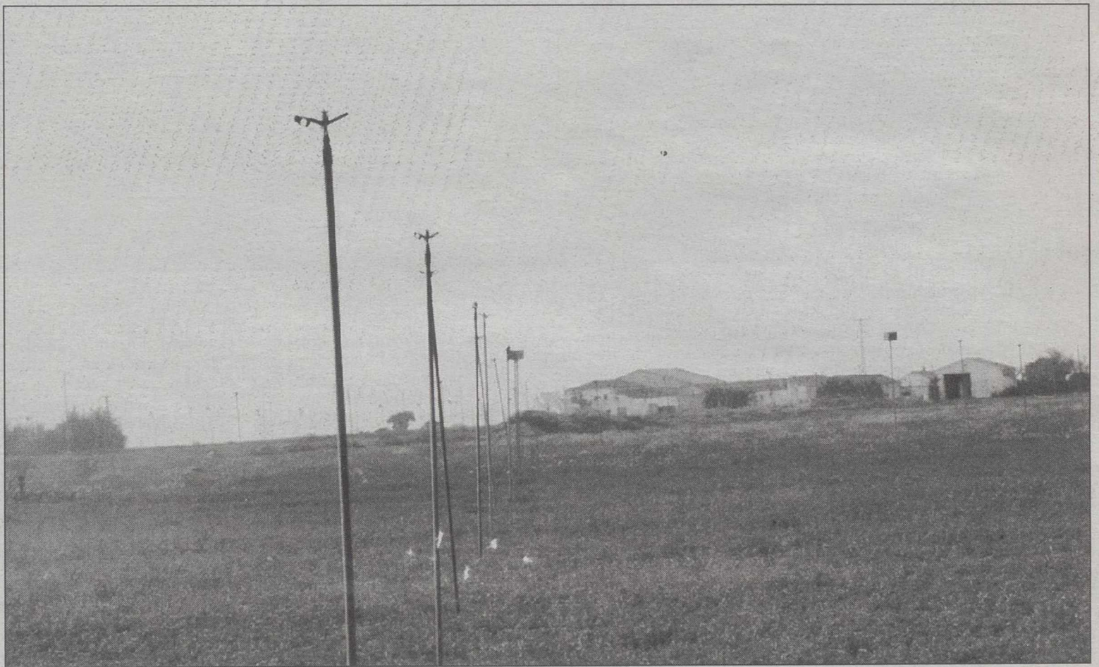
Actuación integral para sustitución de bombeos y nuevas transformaciones.
