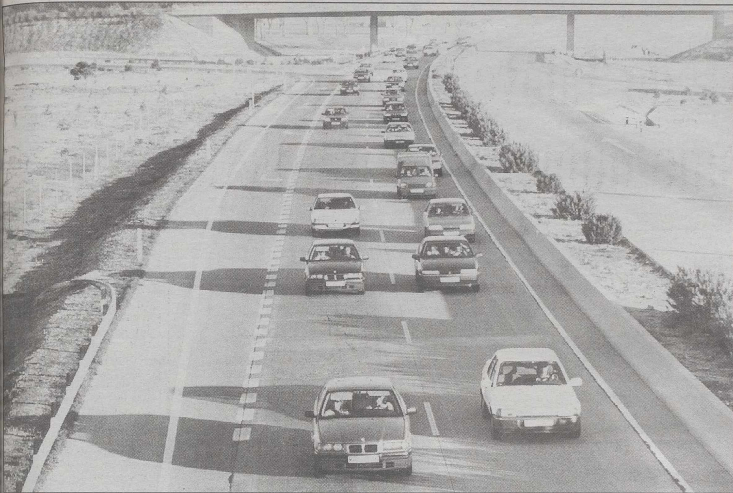
La N-301 y la N-430 son las carreteras de la provincia que pueden registrar más intensidad de tráfico en la provincia el puente.
