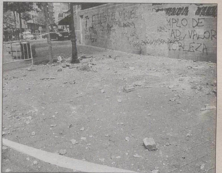
Los cascotes cayeron desde la última vivienda del edificio.
