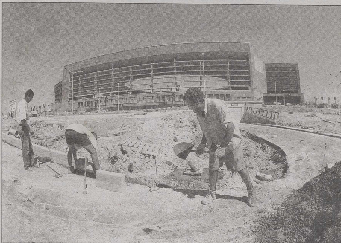
Las obras deben finalizarse lo antes posible para el Mundial de Sevilla.
