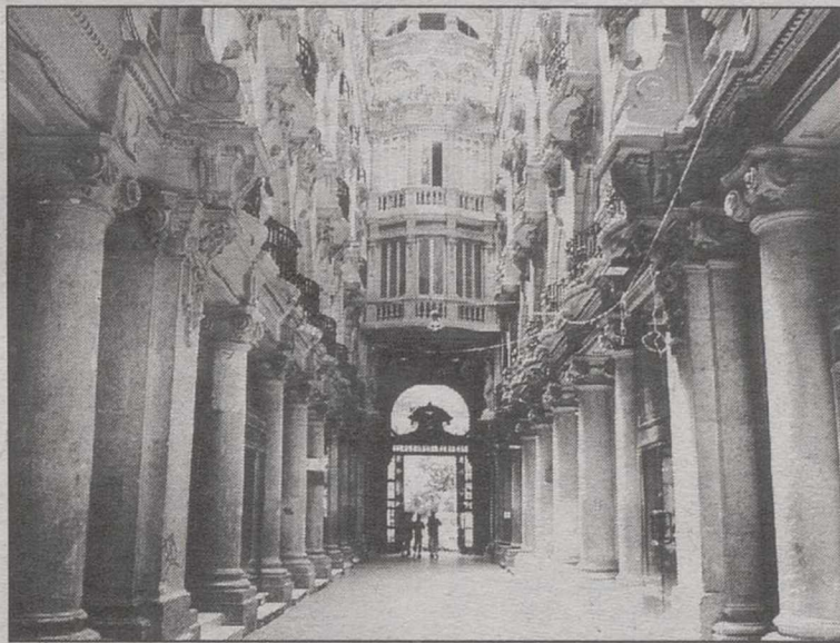
Los trabajos a realizar en el Pasaje Lodares se cifran en 30 millones.
