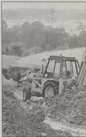
Imagen de limpieza en el oleoducto.
