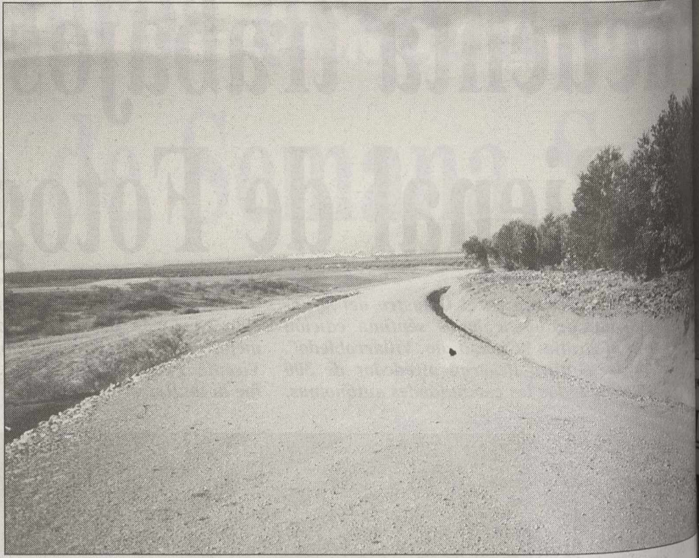
El camino de "Arroyo Espino", en el término municipal, se ha arreglado y ensanchado.
