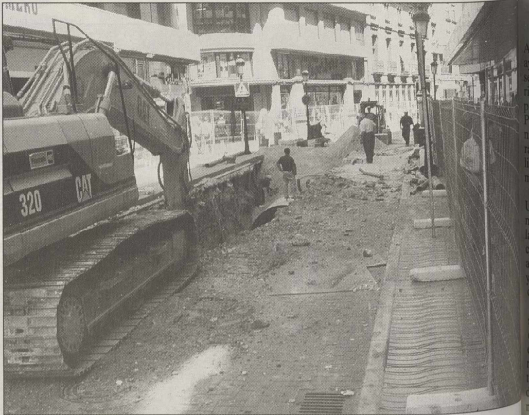
Las obras del colector de la Calle Ancha se detendrán antes de Dionisio Guardiola.
