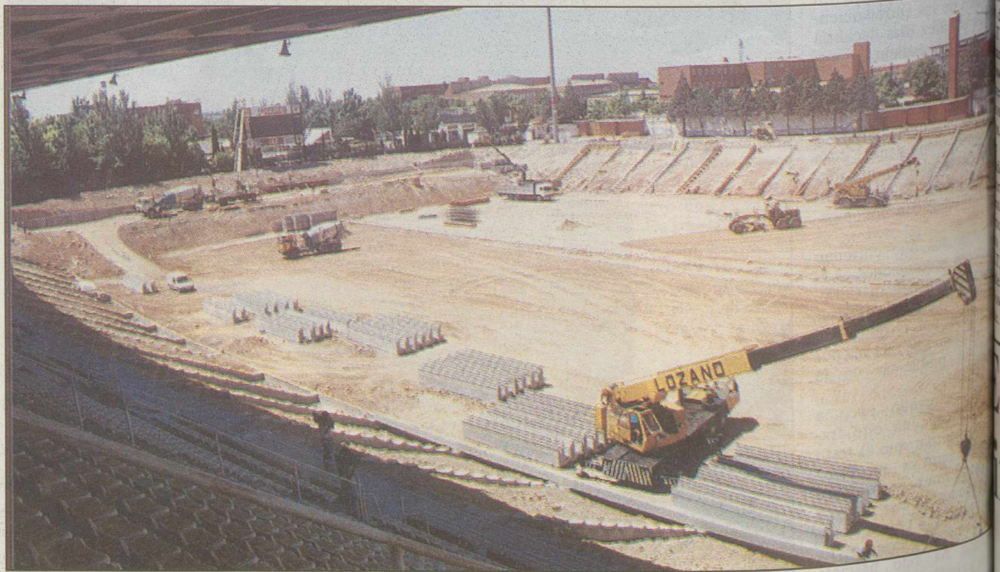
Las gradas ya se están colocando y se espera que en dos semanas Marcador y Preferencia estén listos.
