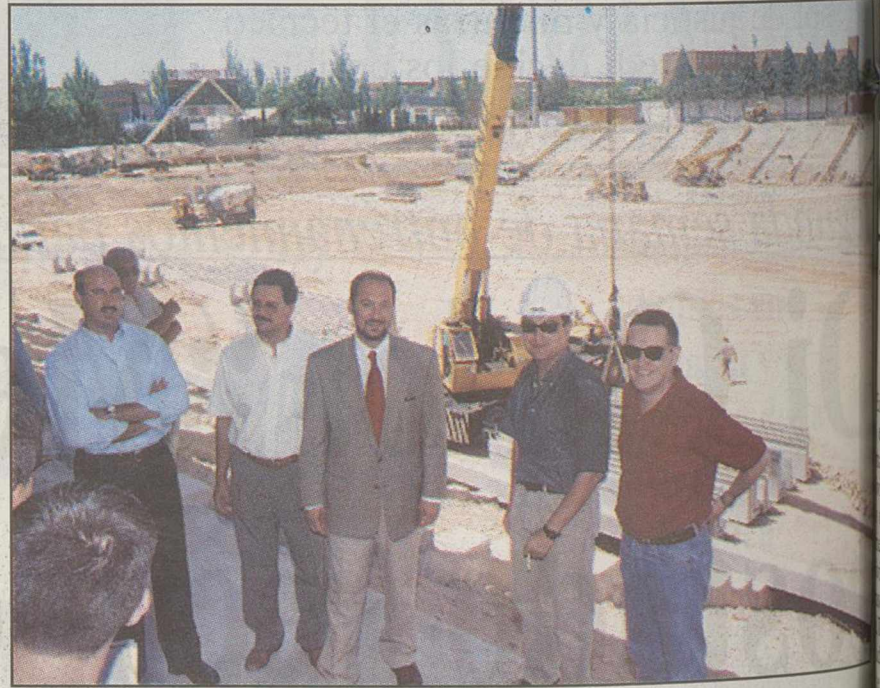
El alcalde, junto a varios concejales y al ingeniero municipal que controla las obras. JESUS MORAN
