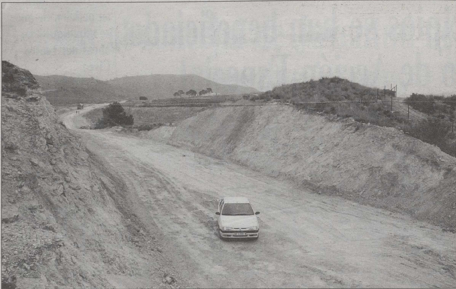
Se subsana el problema de las obras de la carretera del puente de Híjar.
