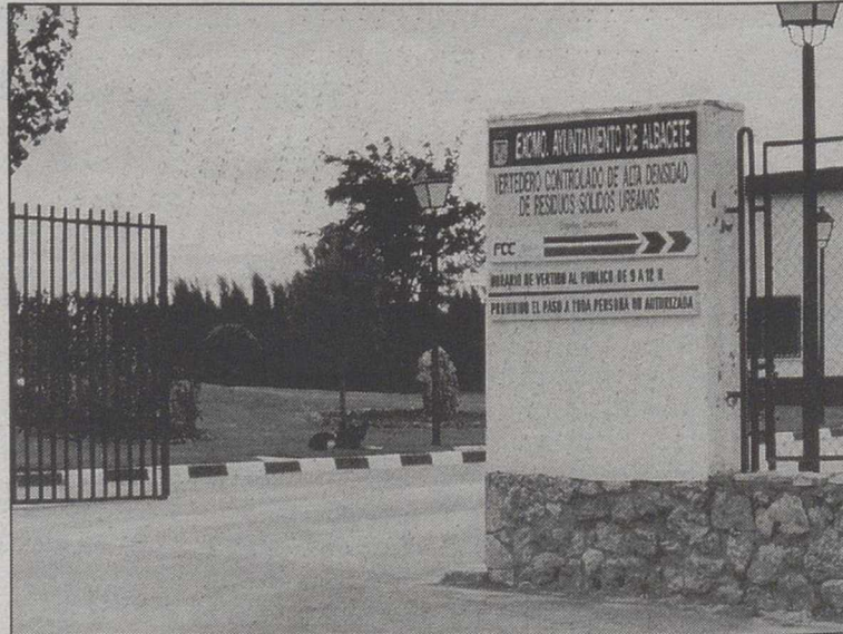
Las pilas están almacenadas en el vertedero, a la espera de su tratamiento.
