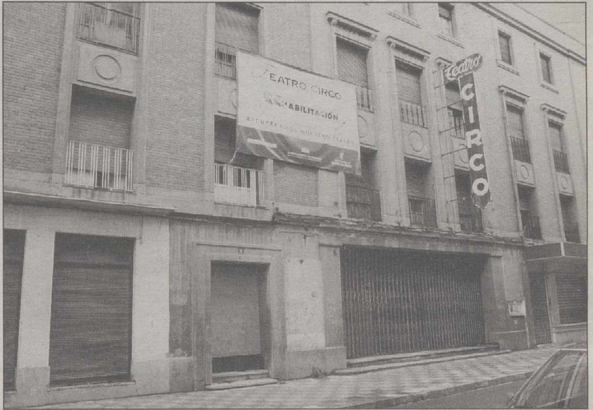
El inicio de las obras del Teatro Circo, pendiente de que el Gobierno proceda a la adjudicación.
