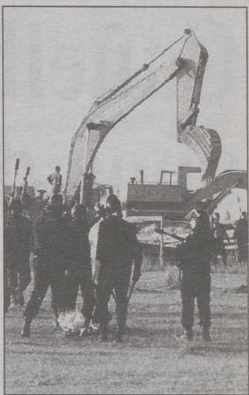
Guardias civiles vigilan las obras.
