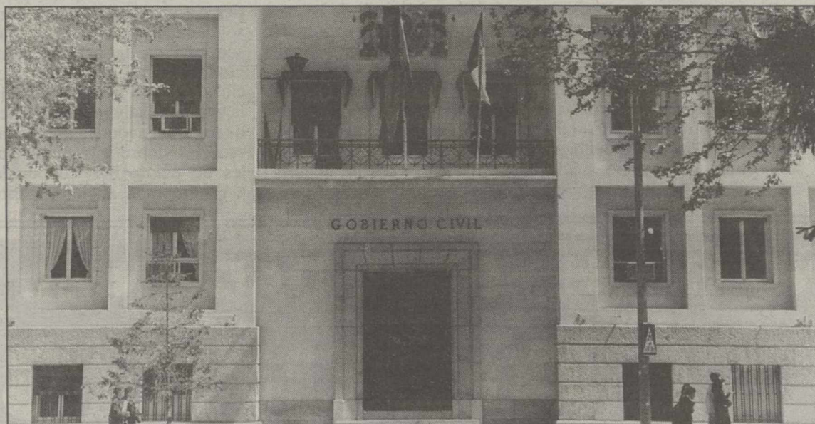
Modificación de la estructura jerárquica dentro de la Administración periférica, uno de los objetivos de la LOFAGE.
