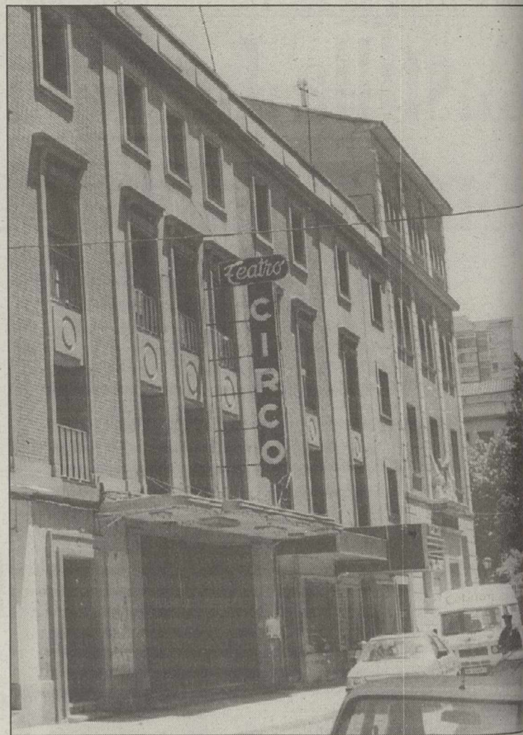
El año 97 se perfila como el inicio de las obras del Teatro Circo.
