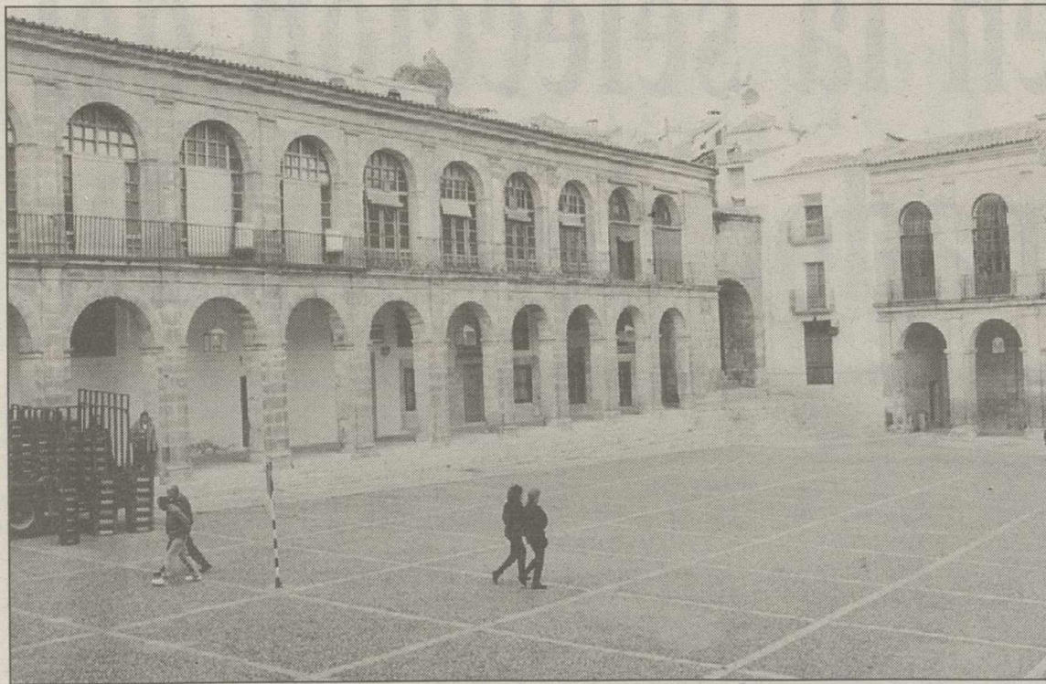
En Alcaraz se aprobaron diversas obras de pavimentación incluidas en el PAE.
