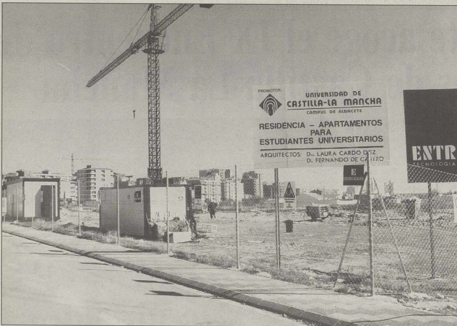
Ayer se colocó la primera piedra de los apartamentos universitarios que serán construidos y explotados por la empresa Entrecanales.
