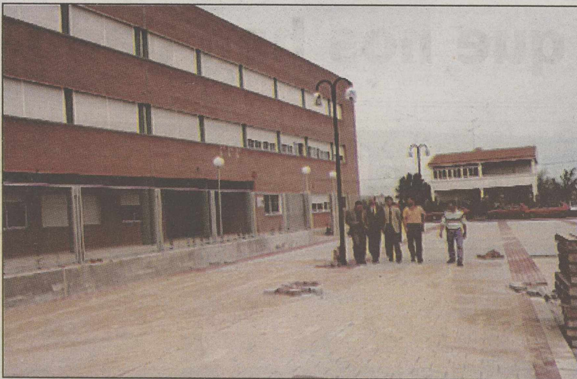
Las obras están a punto de concluir, a falta del adoquinado de algunas zonas.
