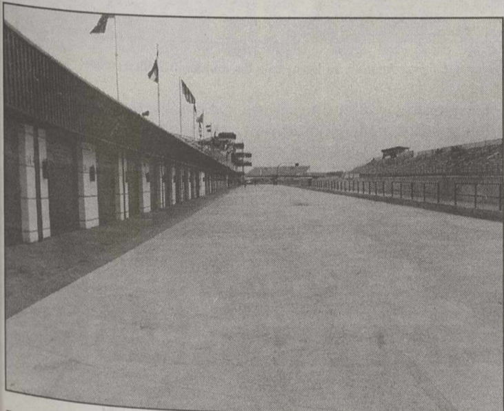
Falta que la Diputación apruebe la modificación de estatutos del Consorcio.
