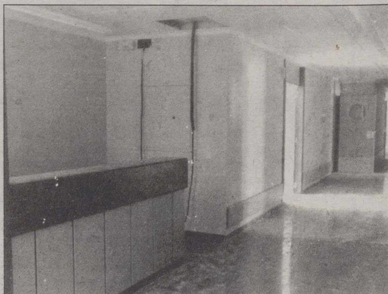
Las obras están acabadas y sólo falta llevar el mobiliario.
