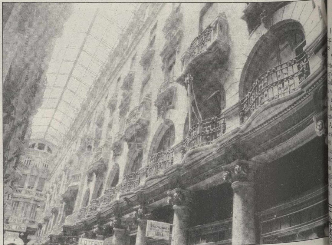
Según el arquitecto, en el plano de ejecución queda claro que no se ha variado la configuración del edificio.
