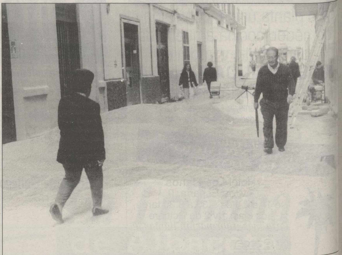
Las obras dejan incomunicada la Calle Zapateros.
