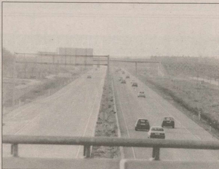
El tráfico fue fluido en la práctica totalidad de las carreteras.
