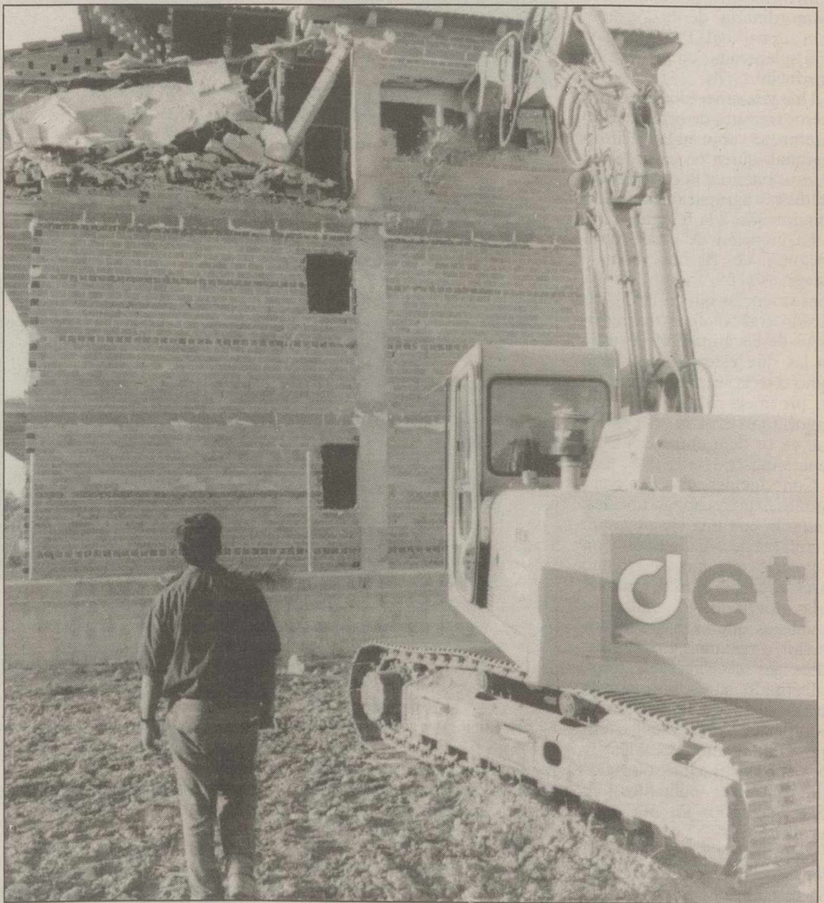
La primera demolición se ha realizado antes de la reunión con los propietarios de ilegales.
