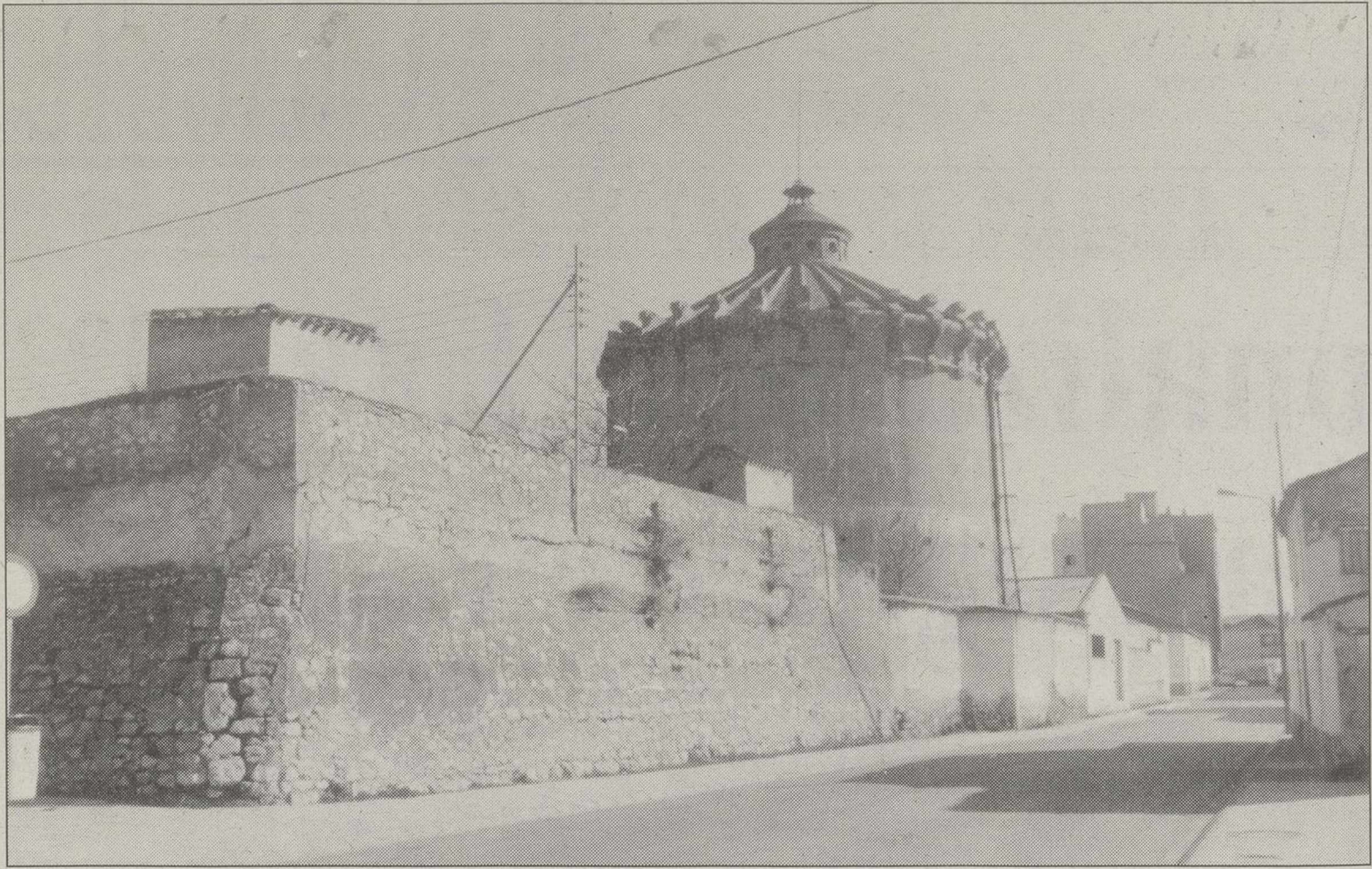
El viejo depósito de agua de la calle del Sol tendrá pronto dos nuevos usos: una biblioteca y un centro de encuentro.
