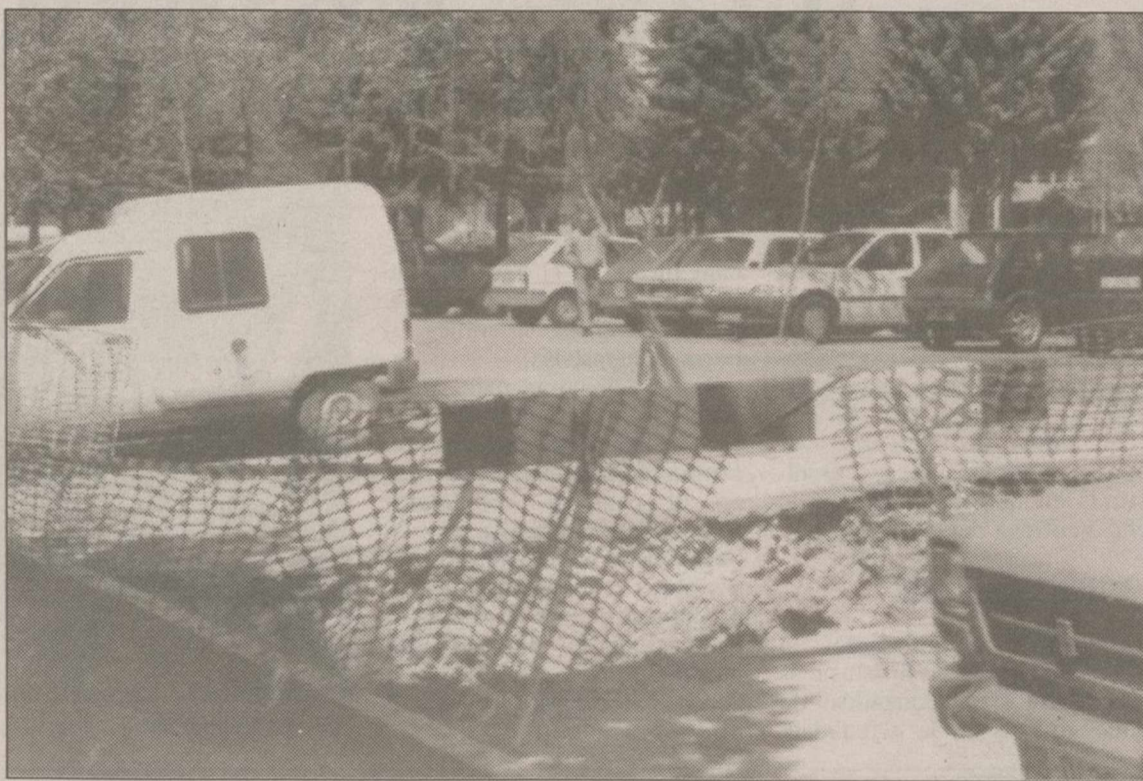
Han comenzado las obras de un nuevo surtidor de gasolina en el aparcamiento del Parque Lineal.
