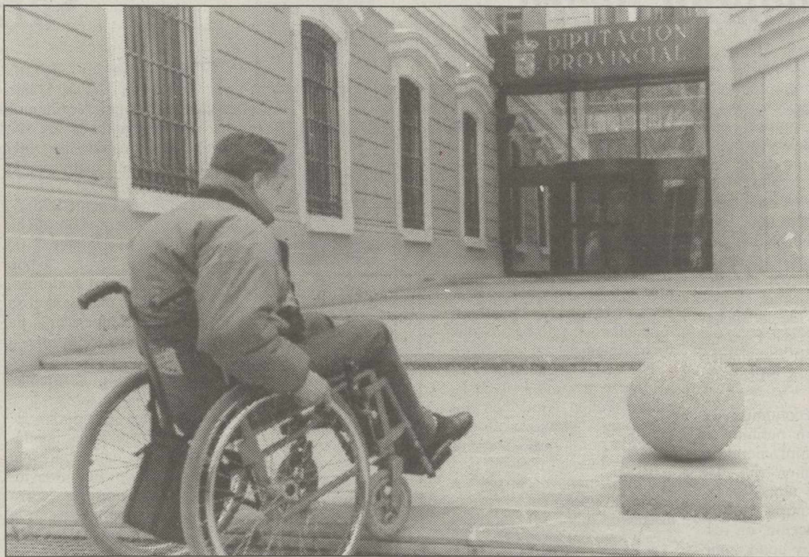
El acceso a la Diputación: escalinatas y una puerta giratoria para "facilitar" el acceso a los minusválidos.
