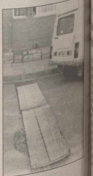
Una zanja peligrosa.
