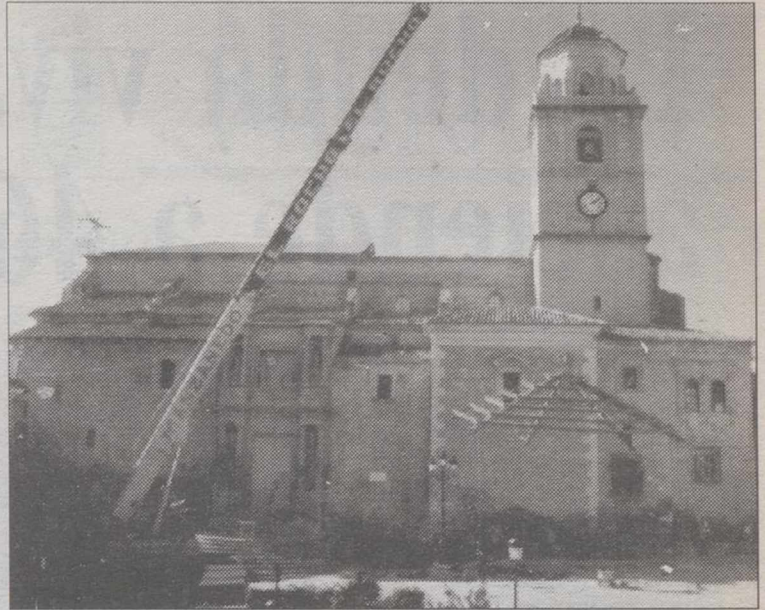
Continúan a buen ritmo los trabajos de restauración.
