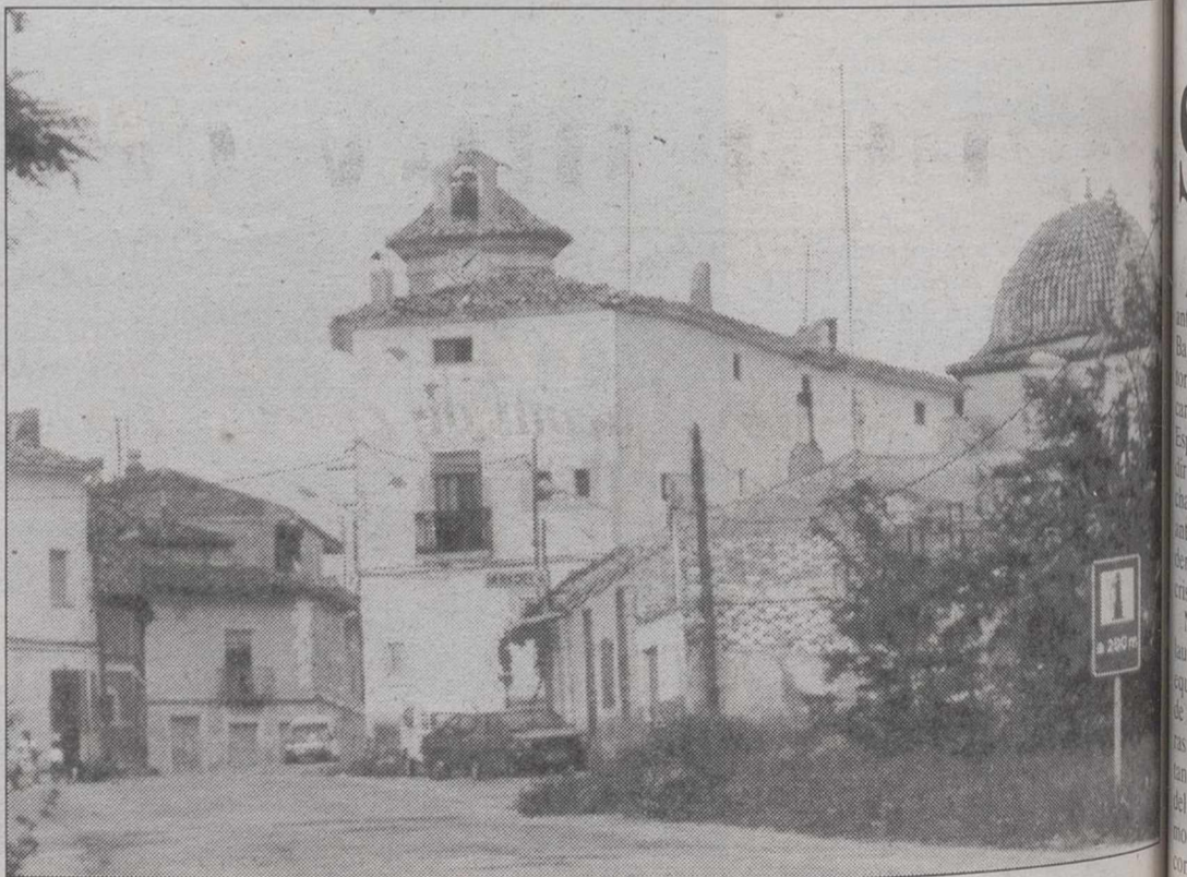
Varias de las obras se efectuarán en la pedanía de Isso.
