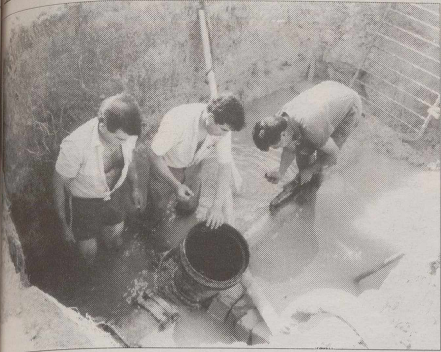
En estos días se está procediendo a sectorizar la red, instalando 100 válvulas.
