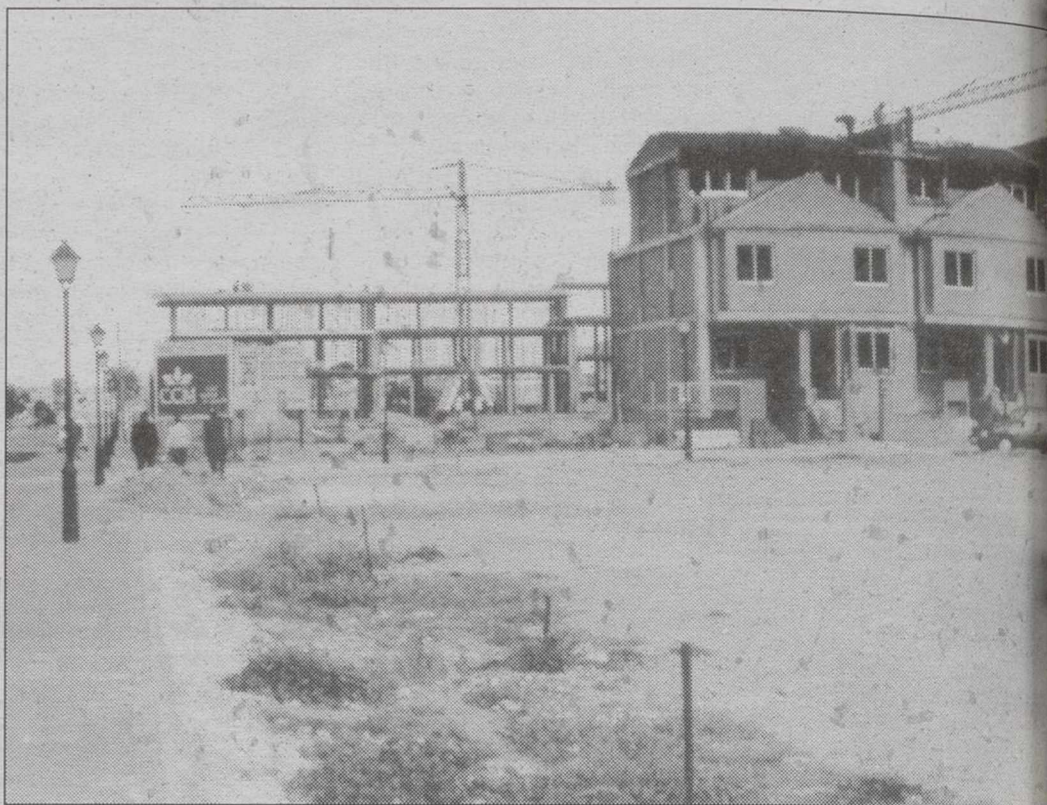
Las estructuras de dos chalets han invadido el terreno de propiedad municipal.
