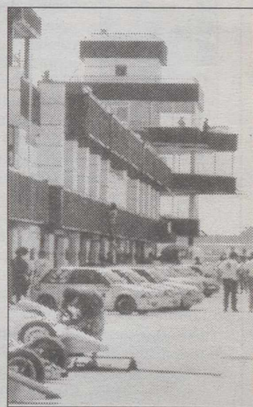
Mejora en la carretera del Circuito.
