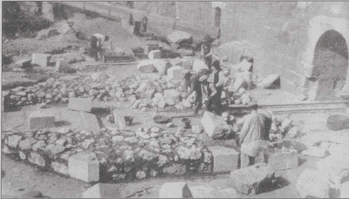
Obras de cantería en la reconstrucción del Pantano de Almansa.
