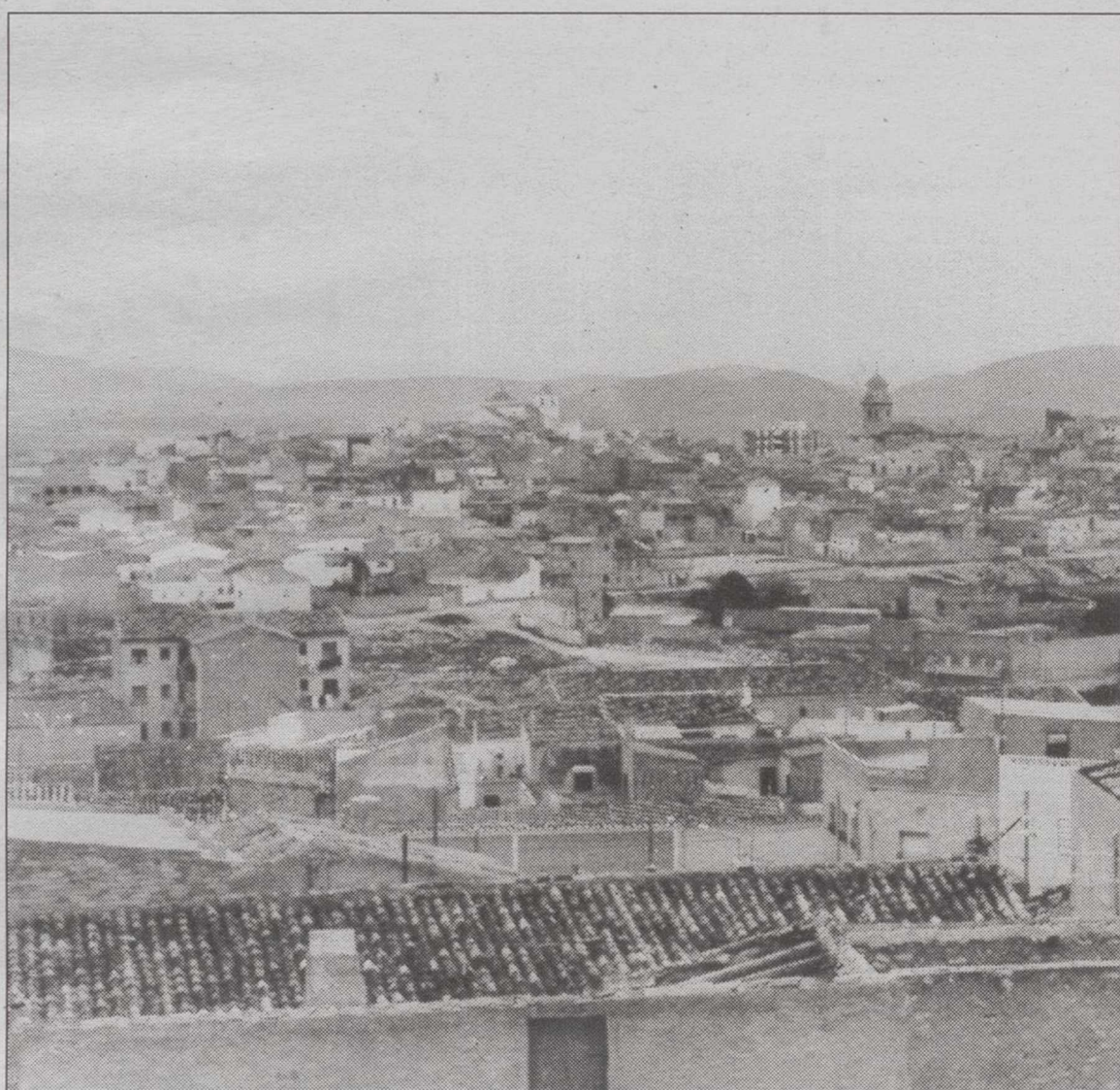
No se resuelven los problemas de contaminación.
