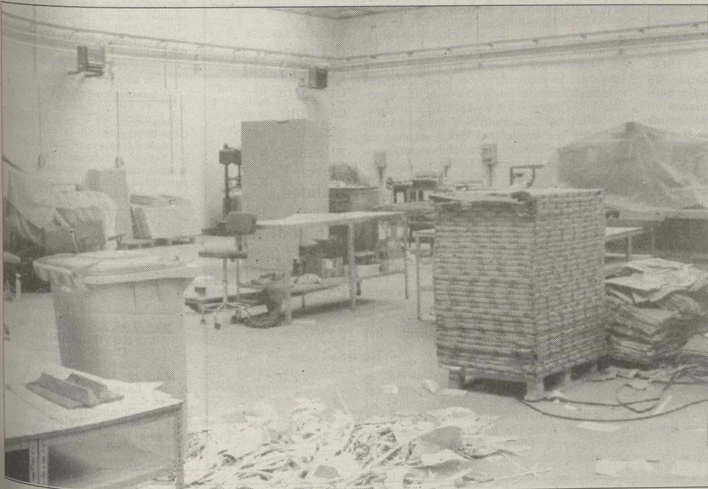
En un estado de abandono, ruina y peligro se encuentra actualmente la Imprenta Provincial de la Diputación.
