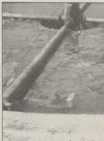
Depuradora de Isso.
