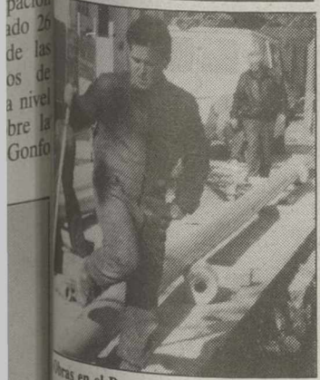
Obras en el Paseo de la Cuba.
