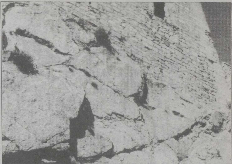
La torre del homenaje se levanta sobre rocas calcáreas dispuestas en estratificación vertical.
