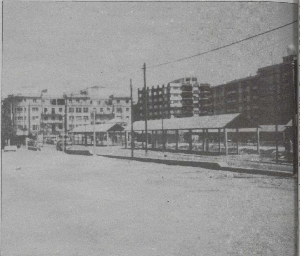
Panorámica del recinto ferial de Hellín después de haber sido remodelado.
