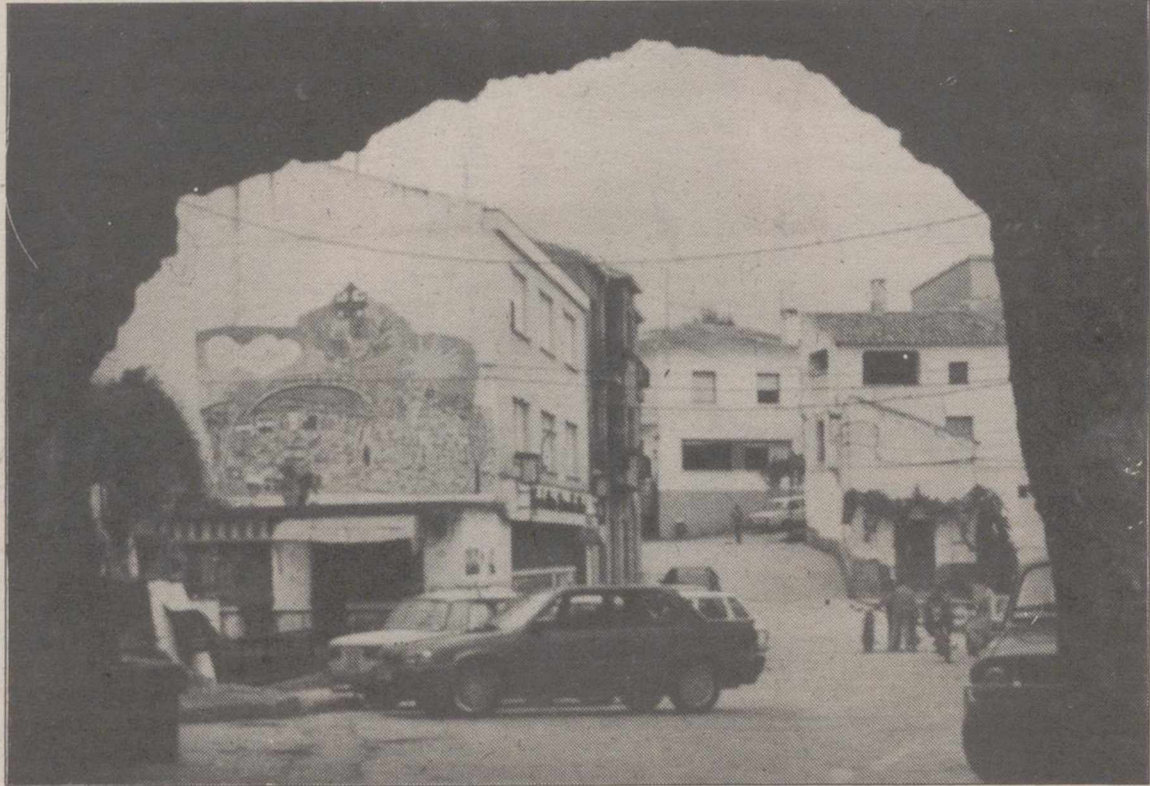
La Escuela-Taller de Letur realiza directamente obras de restauración en casas que ofrecerán servicios de hospedería.
