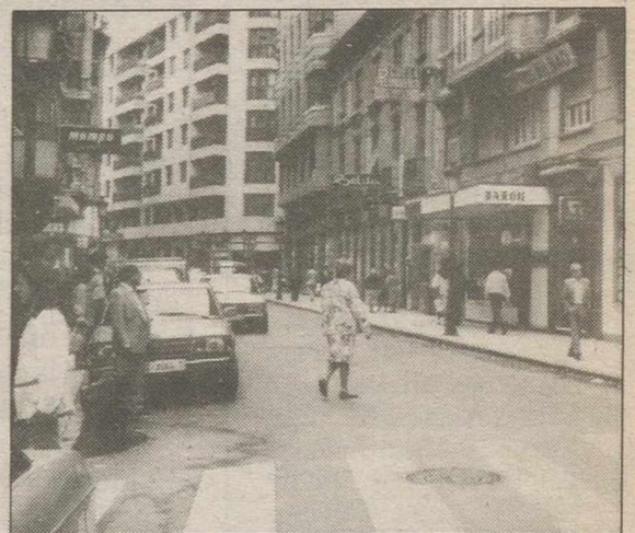
Las obras se prolongarán durante unos dos meses.
