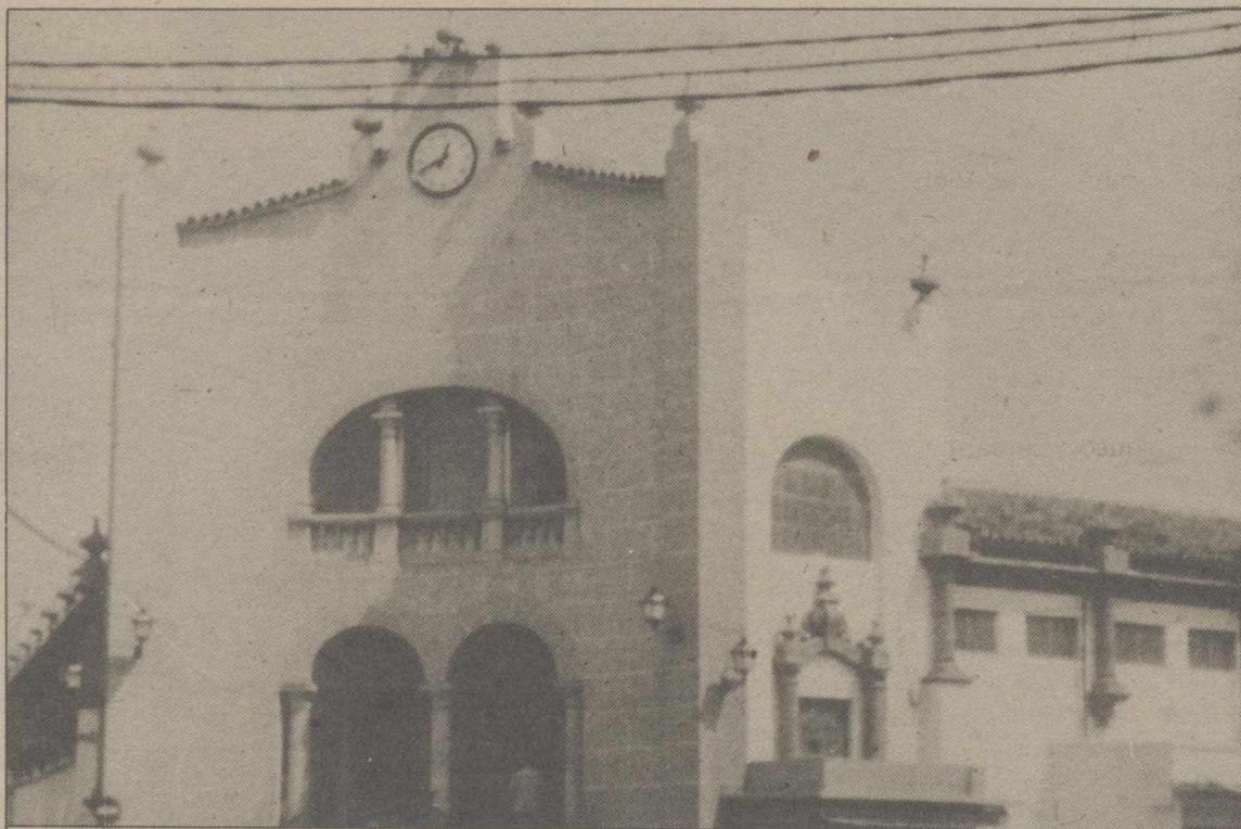
Fachada del mercado municipal de Villarrobledo.
