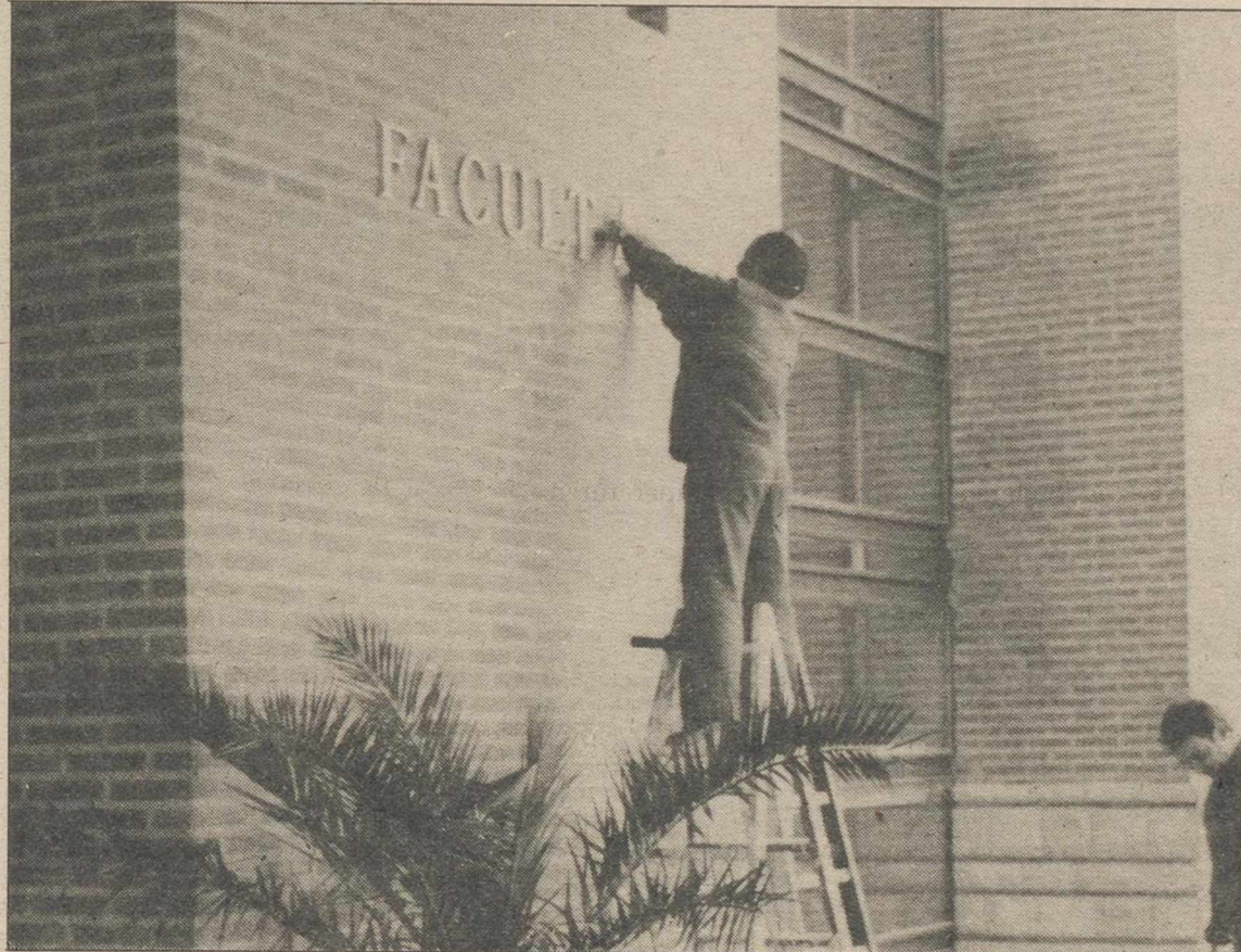
Ayer se ultimaban los preparativos en el campus albacetense
